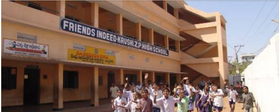
De Babbu Guda school, een van de 4 nieuwbouwscholen, helemaal af!
