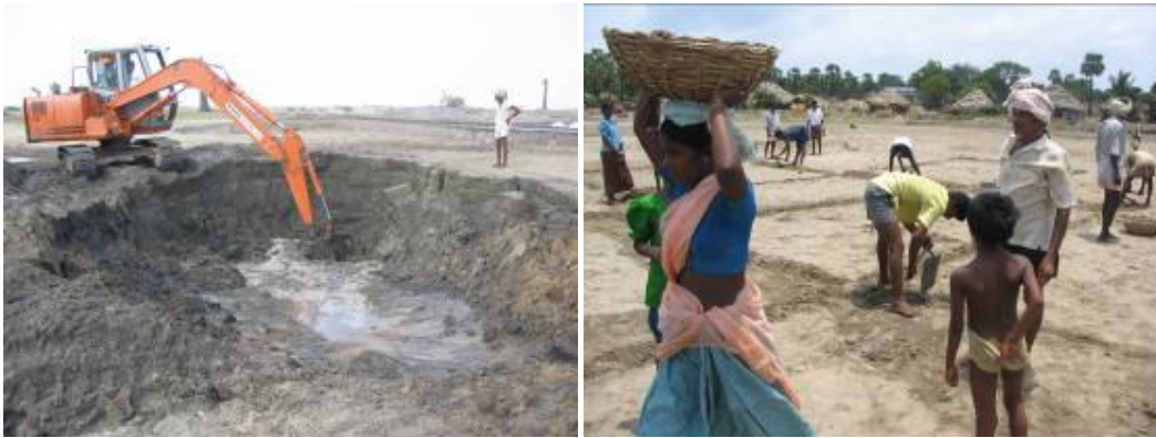
De bronnen worden uitgegraven en de zandlaag wordt verwijderd
