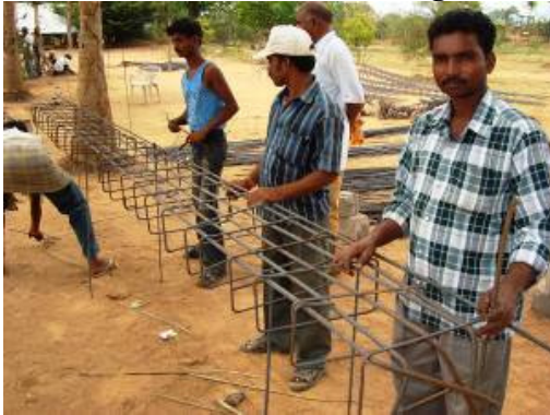
Het vlechtwerk voor de fundering
