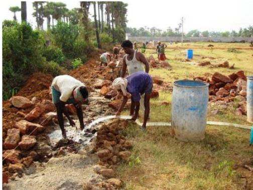
De bouw van de omheining
