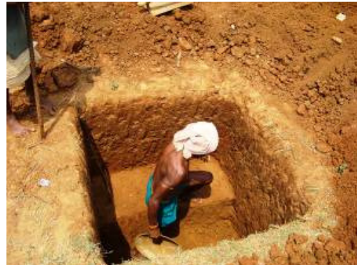
Het graafwerk voor de fundering
