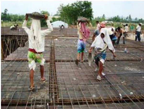
Het dak van het medisch centrum
