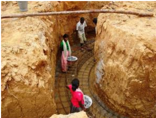
Fundament voor de watertank
