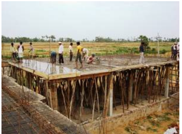
Het dak van de keuken
