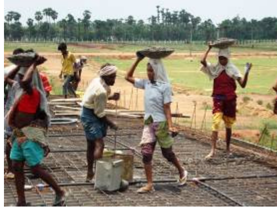
Het beton voor de daken van twee huizen in het kinderdorp wordt gestort
