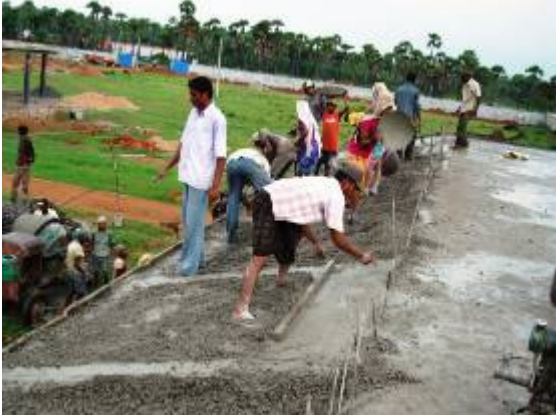
Het beton voor de daken van twee huizen in het kinderdorp wordt gestort
